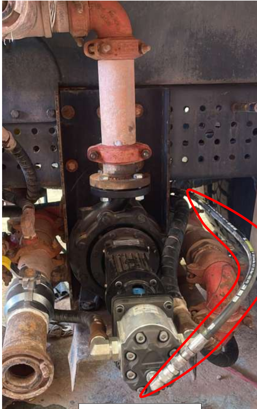
Instalación de manguera de retorno
