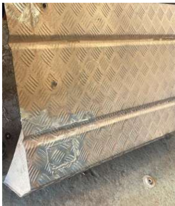
Se ejecuta reparación mediante soldadura en tapa de batería, procediendo posteriormente a su instalación.
